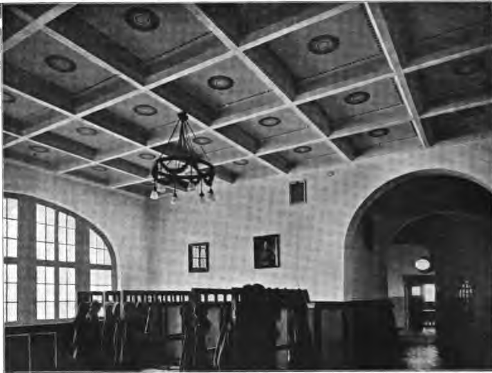
Abb. 63. Eisenbetondecke in der Aula des Ratsgymnasiums zu Osnabrück.
